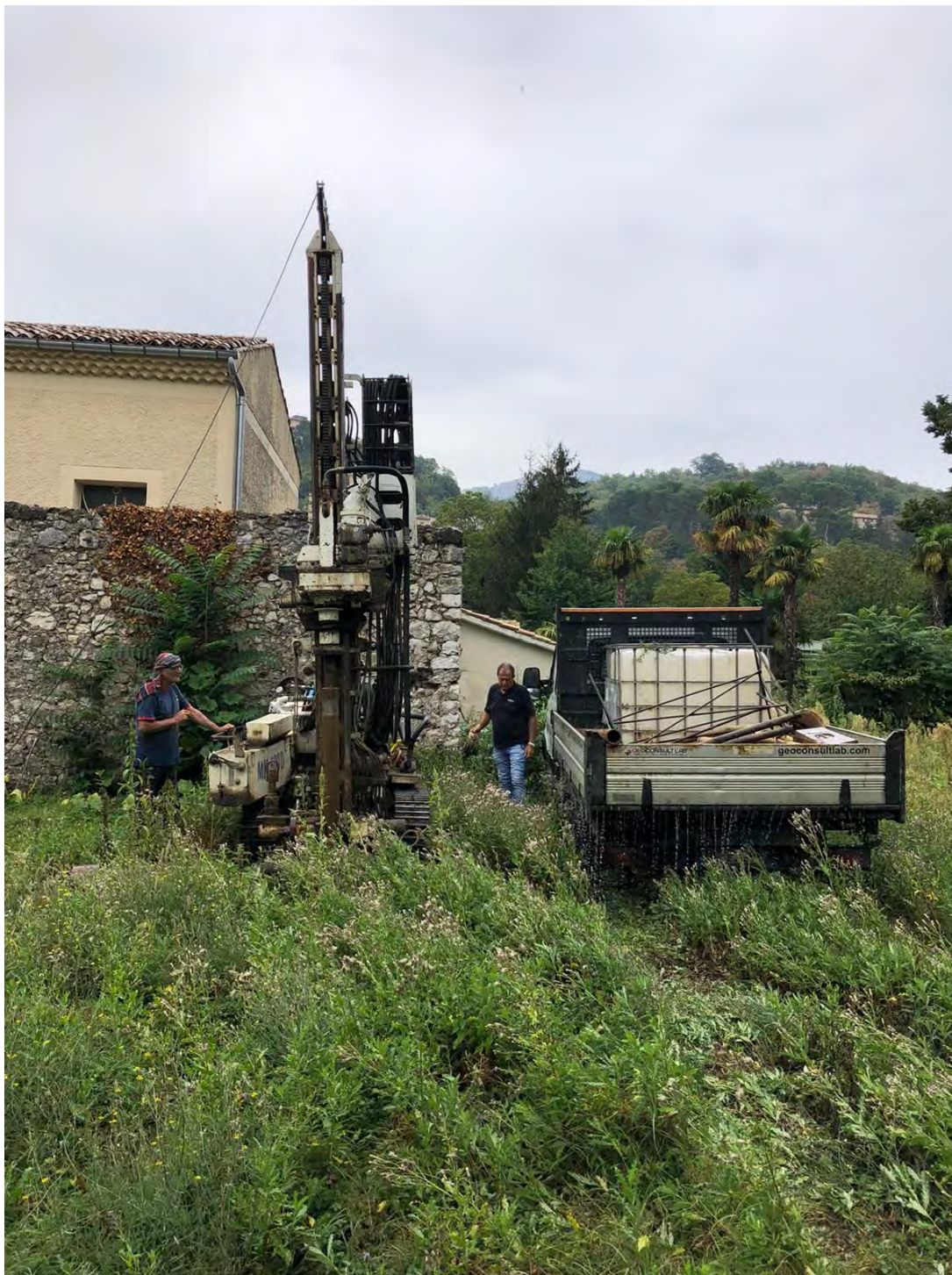
Postazione sondaggio S2
