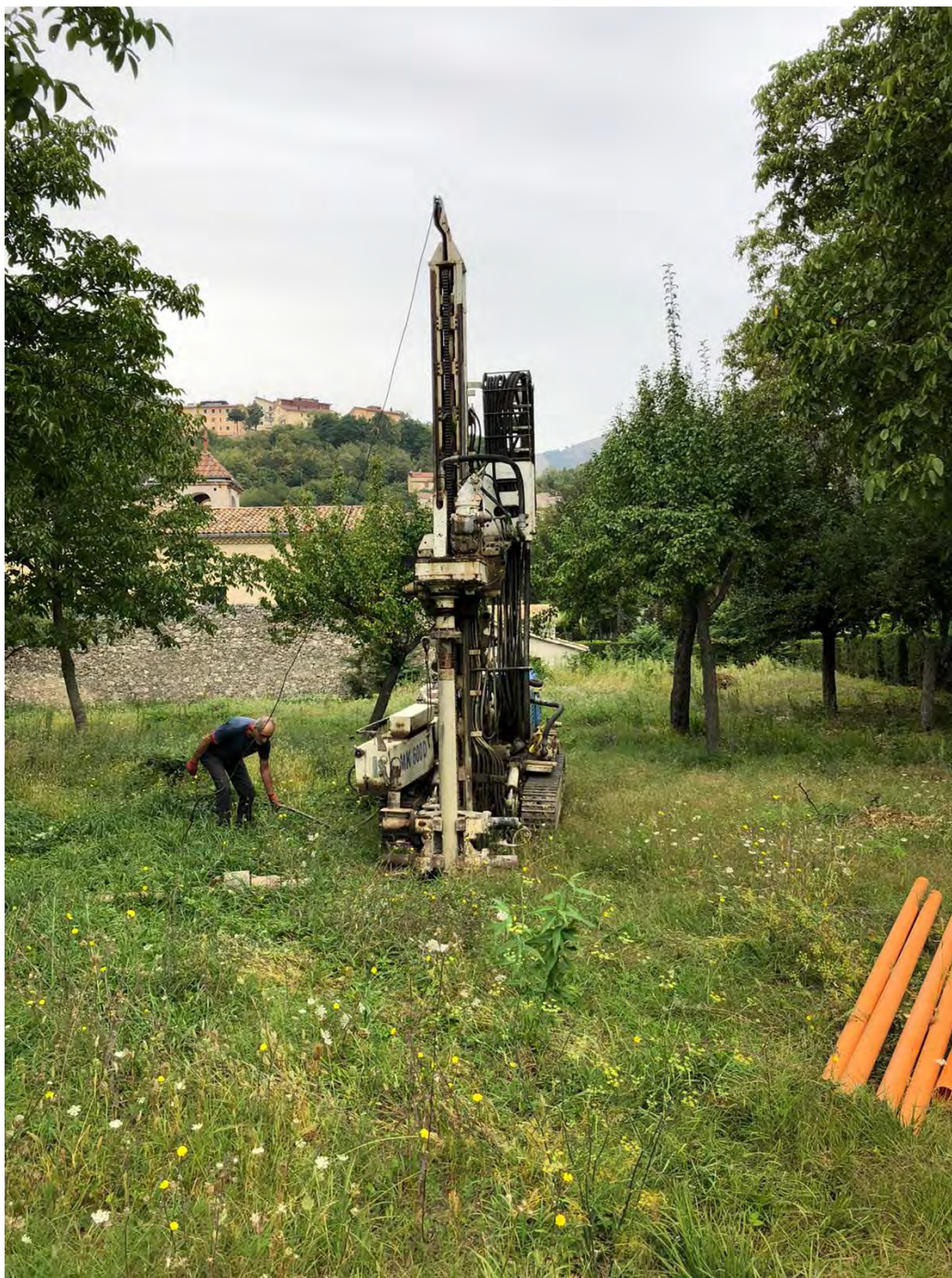
Postazione sondaggio S1
